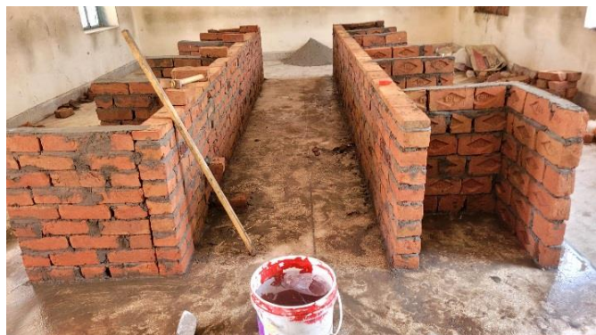
Bauarbeit zur Kochwerkstatt ©Projektschule FSD 2022/23
